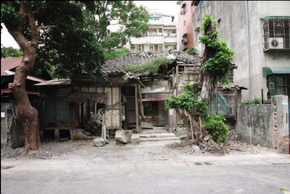
拉拉·阿爾瑪雀紀 台北市齊東街舊屋拆牆計畫 現地製作 2008 版權由藝術家所有
